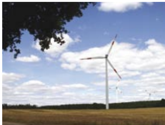
Parc éolien de Puschwitz (Saxe, Allemagne). 10 éoliennes sont érigées dans un paysage de collines présentant des habitats très variés, y compris de nombreux cours d'eau. Entre 2002 et 2006, 76 cadavres de chauves-souris ont été trouvés sous les éoliennes, principalement Noctules communes ( Nyctalus noctula ), Pipistrelles de Nathusius ( Pipistrellus nathusii ), Pipistrelles communes ( Pipistrellus pipistrellus ) et Sérotines bicolores ( Vespertilio murinus ). © M. Lein
