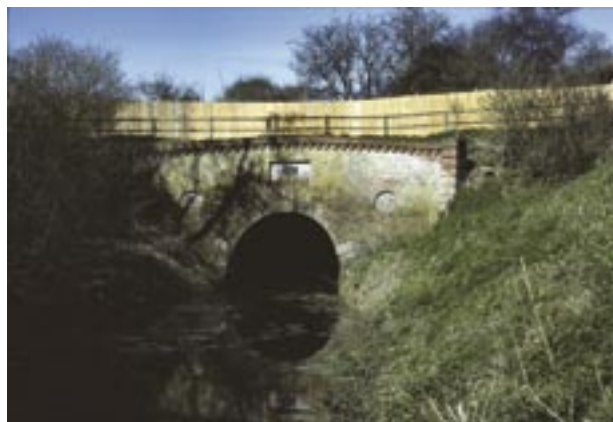
Entrée du tunnel de Greywell, Grande Bretagne.
