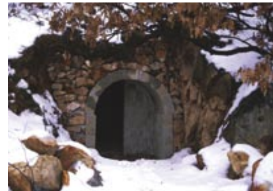
Entrée de la mine Király-bányák après travaux de consolidation.
