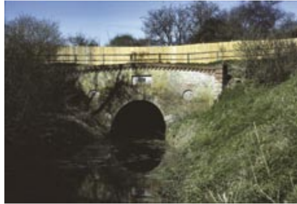
Entrée du tunnel de Greywell, Grande Bretagne.
