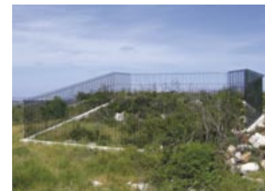
Clôture autour de l'entrée d'une mine importante au Portugal.
