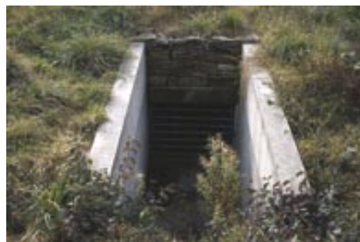
Grille à l'entrée d'une petite mine sous le niveau du sol, Grande Bretagne.
